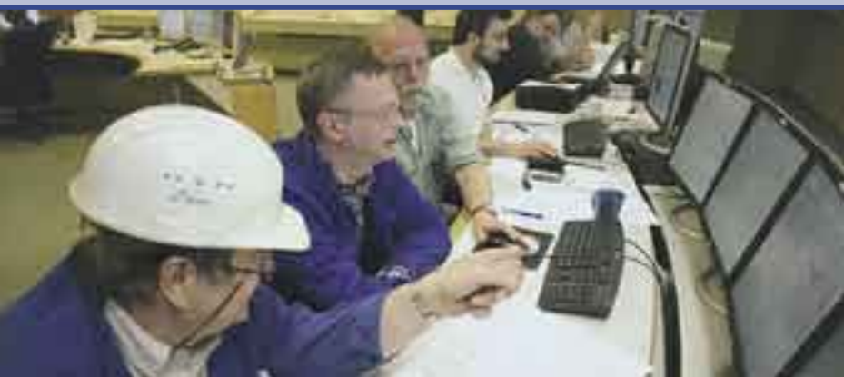
Leitwarte im Heizkraftwerk
